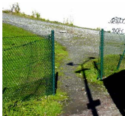
Clôture sectionnée le long du quai 1
