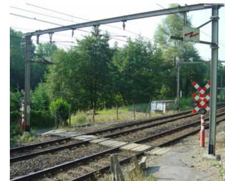
Passage à niveau pour piétons de Sauheid
