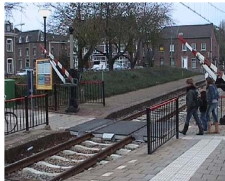
Passage à niveau pour piétons entièrement équipé (barrières, feux et sonnerie) en gare d'Eisden (Pays-Bas)
