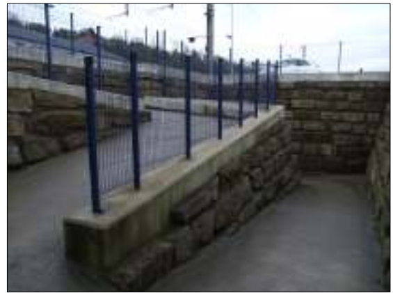
Le passage souterrain d'Hamoir était nécessaire pour garantir la sécurité des voyageurs. Seul inconvenient, l'absence d'un escalier, qui, couplé au plan incliné (réservé aux PMR), favoriserait un accès rapide aux voies. Le détour demeure ici conséquent.
