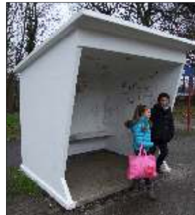
À Barvaux, ces personnes préfèrent attendre leur train debout, ce qui se comprend vu l'état du banc. Souvent tagués, les abris isolent l'usager par leurs parois opaques. En résulte un problème de visibilité – pas de vue sur le train en approche – et de sécurité – une agression commise entre ces murs demeure bien discrète.
