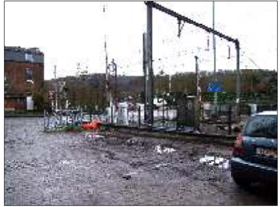
À Tilff, le parking, boueux et défoncé, n'engage guère à y laisser sa voiture. Quitter celle-ci « proprement » relève du défi. Les râteliers, non couverts, exposent les vélos et leurs propriétaires aux intempéries.
