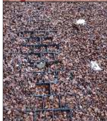
À Comblain-la-Tour, le revêtement de sol composé de grillage et de gravillons est inadapté. Sous l'effet du passage de voyageurs, les pierres couvrent la ligne de sécurité rendue peu visible, ou découvrent le grillage, ce qui représente alors un danger de chute. Un haut talon pris dans l'épaisseur du grillage fera inévitablement trébucher le piéton.
