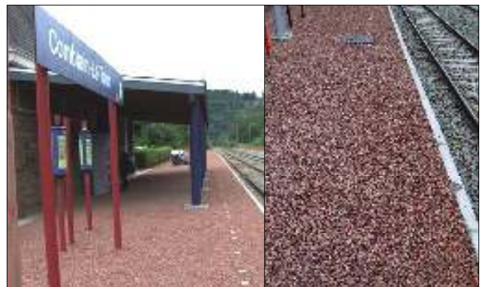
À Comblain-la-Tour, le revêtement de sol composé de grillage et de gravillons est inadapté. Sous l'effet du passage de voyageurs, les pierres couvrent la ligne de sécurité rendue peu visible, ou découvrent le grillage, ce qui représente alors un danger de chute. Un haut talon pris dans l'épaisseur du grillage fera inévitablement trébucher le piéton.
