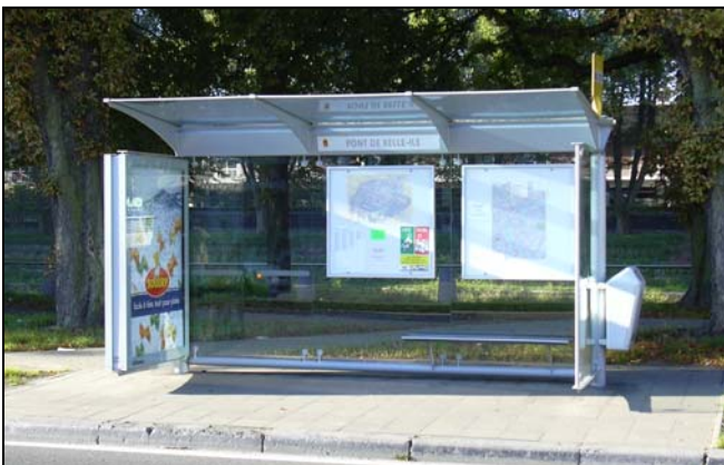
La plupart des abribus n'offrent pas des parois latérales allant du sol à la toiture. Dans bien des cas, le nom de l'arrêt n'est pas visible depuis l'intérieur des véhicules et les sièges sont souvent mal disposés (devant les horaires ou le plan du réseau). © ACTP
