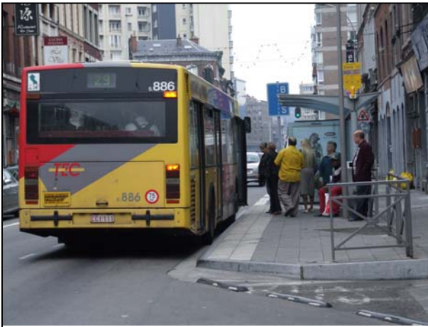
Les quais en avancée permettent un accostage de qualité (Liège, arrêt Longdoz) © ACTP
