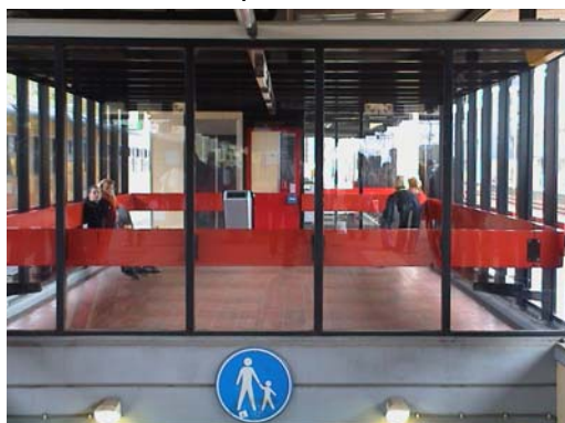
Abri de quai fermé en gare d'Herleen (Pays-Bas). © ACTP
