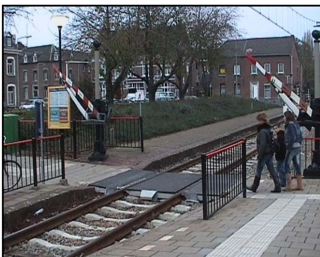
Exemple de passage à niveau entièrement équipé (barrières, feux et sonnerie) en gare de Eisden (Pays-Bas)
