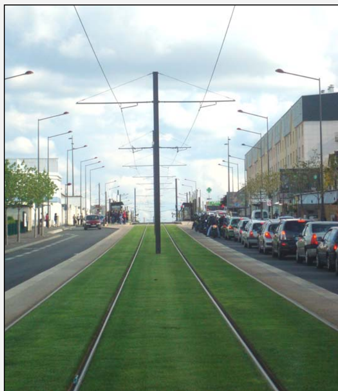
Tram du Mans : site propre engazonné
