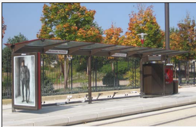
Tram du Mans : station « Théodore Monod ». Les arrêts sont tous équipés d'un afficheur des prochains départs en temps réel et d'un distributeur automatique de titres de transport. Seul regret, le nom de l'arrêt, mentionné au fond de l'abri, n'est guère visible depuis les convois.
