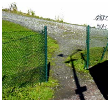
Clôture sectionnée le long du quai 1
