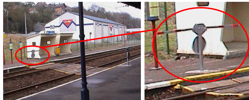
Le système de barrière mis en place par la SNCB était pour le moins inefficace
