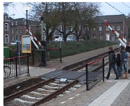
Passage à niveau pour piétons entièrement équipé (barrières, feux et sonnerie) en gare d'Eisden (Pays-Bas)
