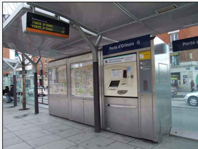
T3 : aménagement d'une station
