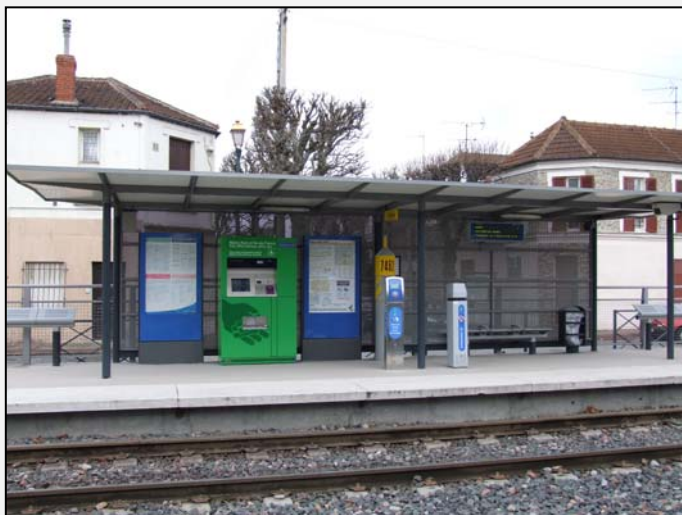
T4 : aménagement d'une station
