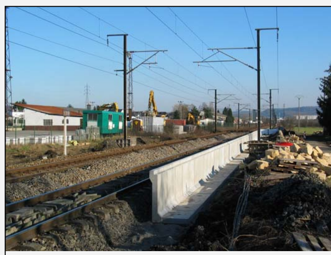
Aubange : travaux de réfection des quais © Amis du Rail Halanzy
