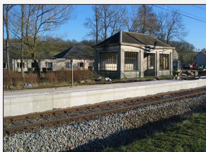
Messancy : travaux de réfection des quais © Amis du Rail Halanzy
