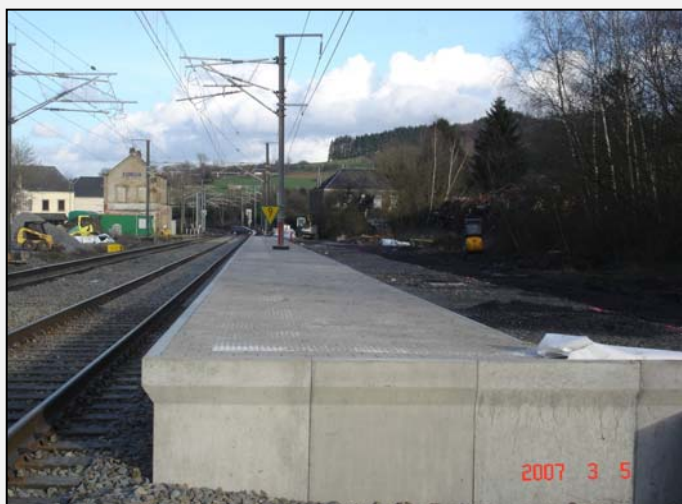
Halanzy : travaux de réfection des quais © Amis du Rail Halanzy
