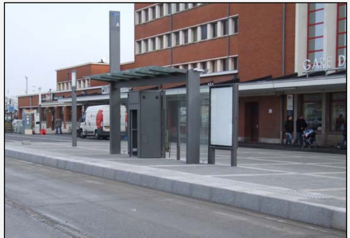
Si, de manière générale, l'aménagement des stations est bien pensé, on regrettera toutefois l'absence de protection latérale sur les abris. Ils se révéleront vite insuffisants en cas de fortes pluies. Sur cette photo prise devant la gare SNCF, on remarque le soin apporté à la connexion avec le train (distance minimale et cheminement de plain-pied). © ACTP
