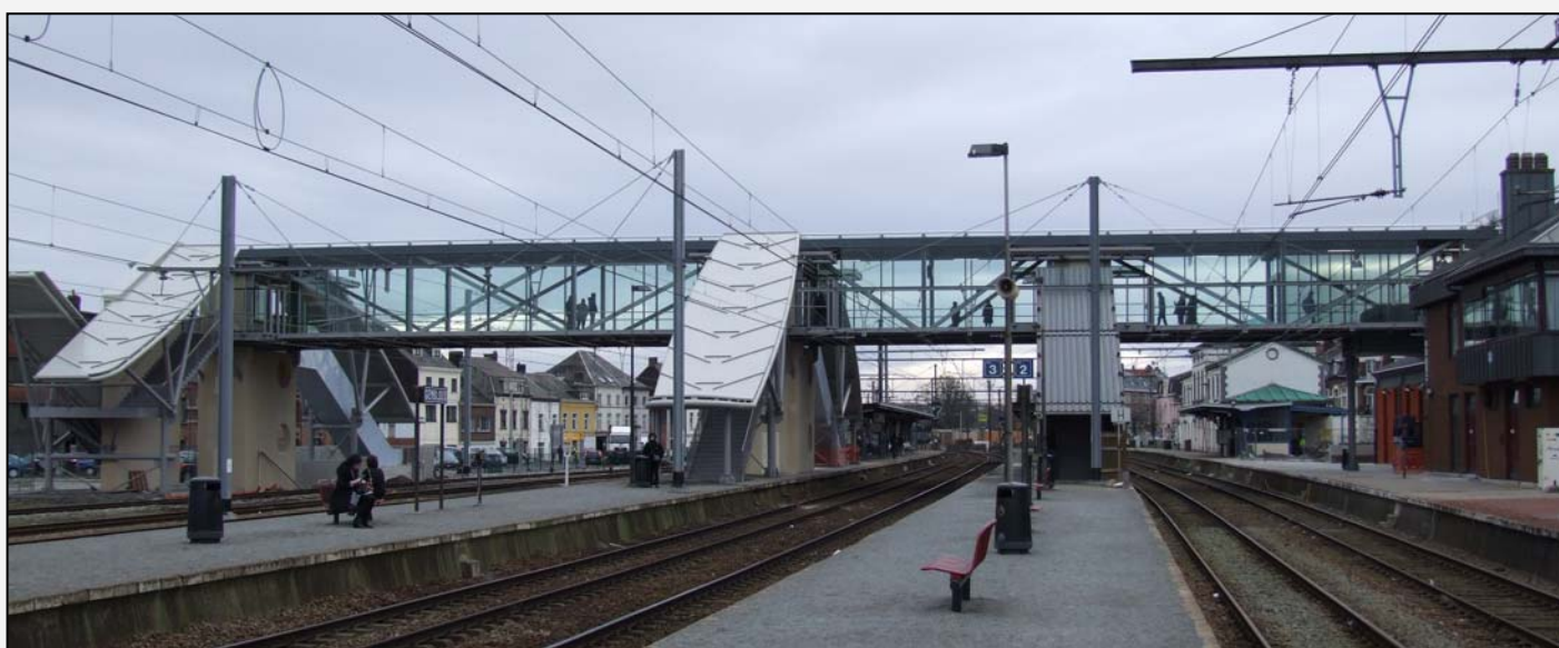
La passerelle vue depuis le quai 2
