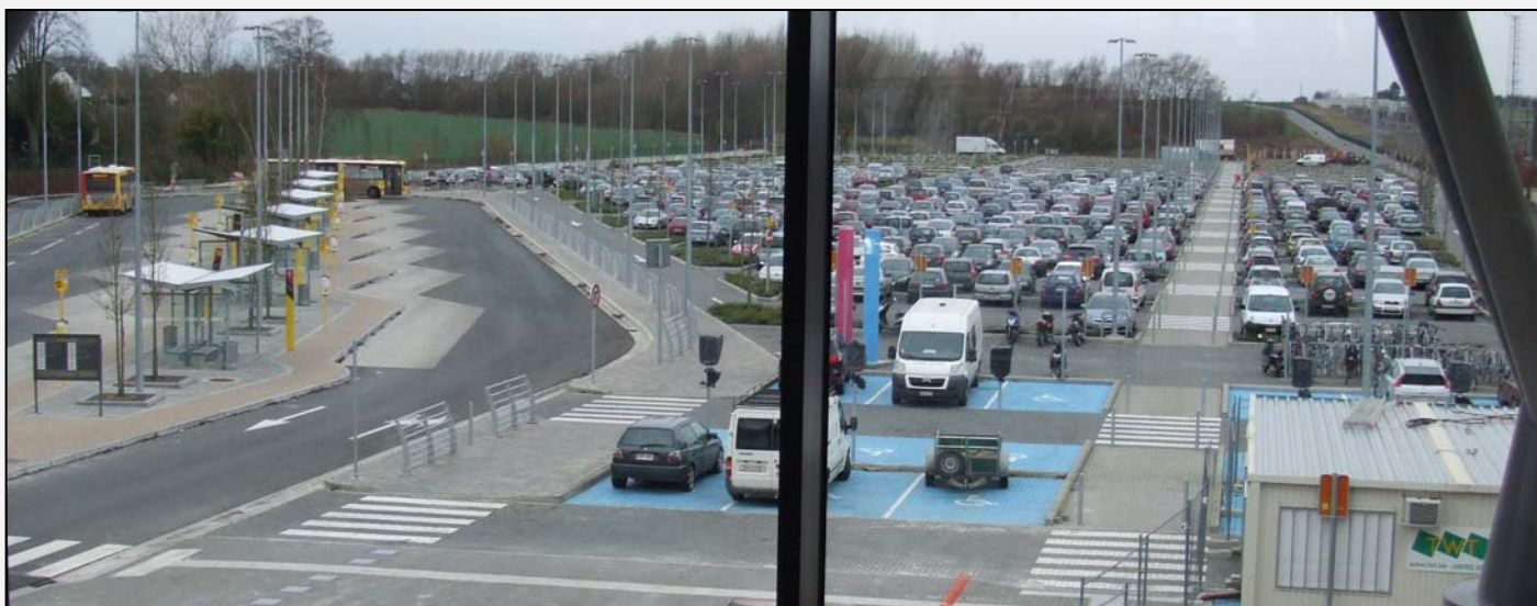
La gare TEC et le parking vus depuis le bâtiment voyageurs. A peine 50 mètres séparent la gare SNCB de la gare TEC. Dommage que cette courte distance ne puisse être parcourue à couvert : le passage aérien pourrait être prolongé jusqu'aux quais bus. Cette solution permettrait en outre d'éviter les traversées de voiries. © ACTP
