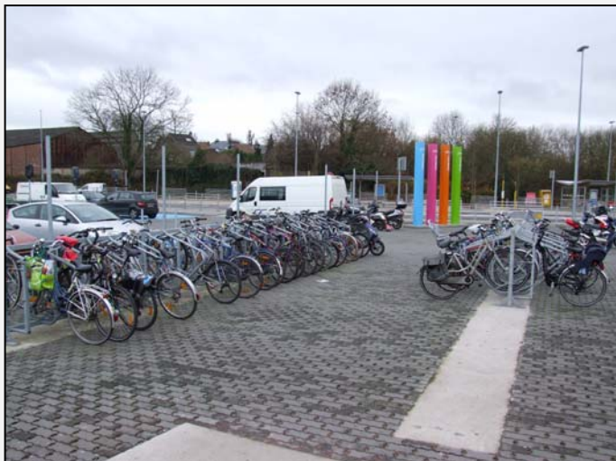
Le parking deux-roues n'est pas couvert et est déjà saturé © ACTP
