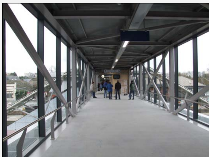
La passerelle surplombant les voies
