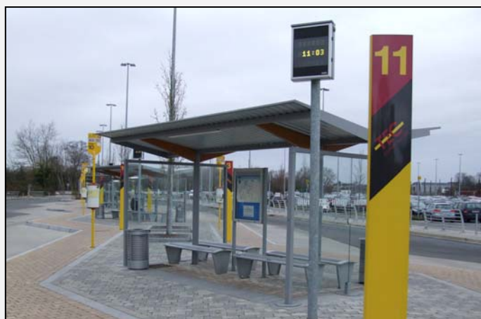
Chaque abri est équipé d'une poubelle et de deux sièges entre lesquels est judicieusement placé un plan du réseau. Les quais sont facilement identifiables grâce aux potences aux couleurs du TEC mentionnant leur numéro. Dommage toutefois que les horaires ne soient repris que dans des tambours sur les poteaux d'arrêt et donc, pas consultables à couvert. © ACTP
