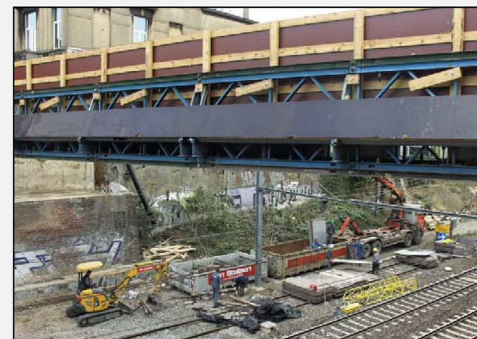
Rue du Sceptre : passerelle provisoire mise en place dans l'attente du nouveau pont. http://picasaweb.google.fr/SebastienR4/
