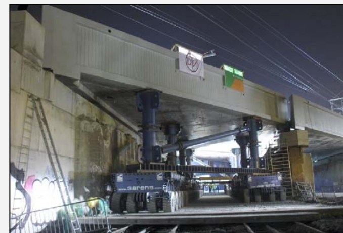
Pont d'Etterbeek : mise en place du nouveau pont encore sur les remorques de transport http://picasaweb.google.fr/SebastienR4/
