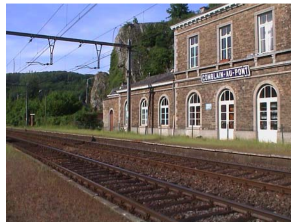
Situation actuelle du Pang de Comblain-au-Pont : on remarque la présence d'abris et de poteaux d'éclairage. Seules les plaques d'arrêt manquent pour que les quais soient complètement en état.
