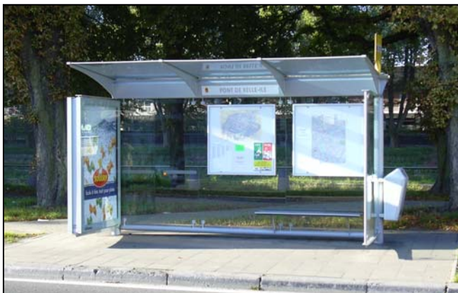
La plupart des abribus n'offrent pas des parois latérales allant du sol à la toiture. Dans bien des cas, le nom de l'arrêt n'est pas visible depuis l'intérieur des véhicules et les sièges sont souvent mal disposés (devant les horaires ou le plan du réseau). © ACTP
