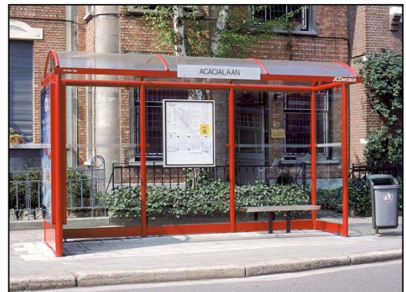
Cet abri dispose de bonnes parois latérales assurant une protection contre les pluies obliques. Le nom de l'arrêt figure bien en évidence et le siège est judicieusement décalé par rapport à la valve d'information. © ACTP
